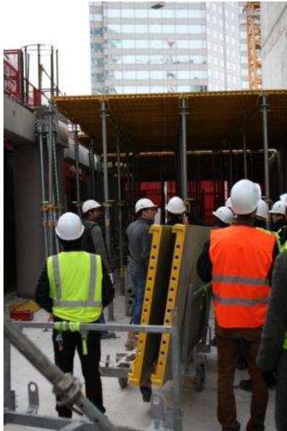
Coffrage des planchers
