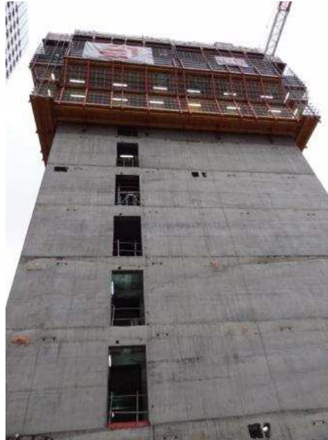
Vue sur le noyau et le coffrage autogrimpant
